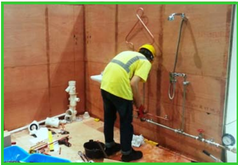
賽事正進行供水配管安裝
