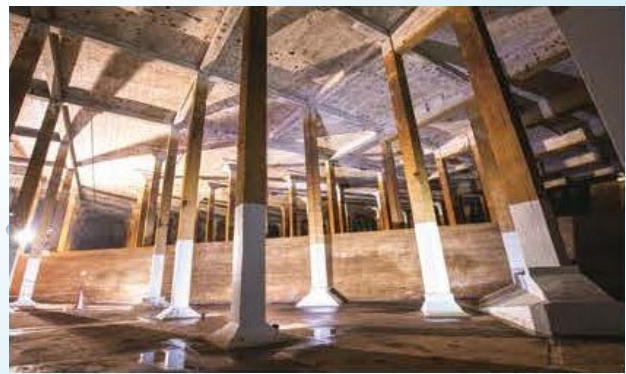
雅賓利配水庫：排水後的內部情況
